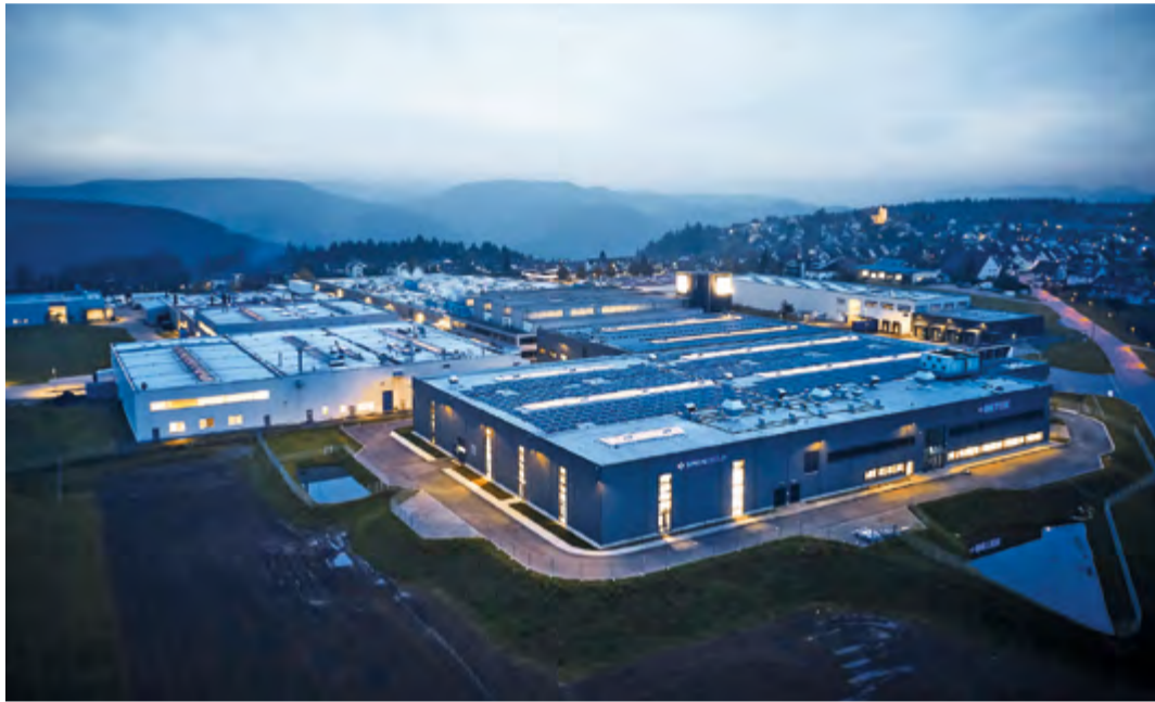
Um die in den Arbeitsprozessen eingesetzte Energie möglichst effizient zu nutzen, entwickelte Maurer Energie- und Ingenieurleistungen ein Wärmepumpen-, Kühlwasser- und Klimatisierungskonzept.
