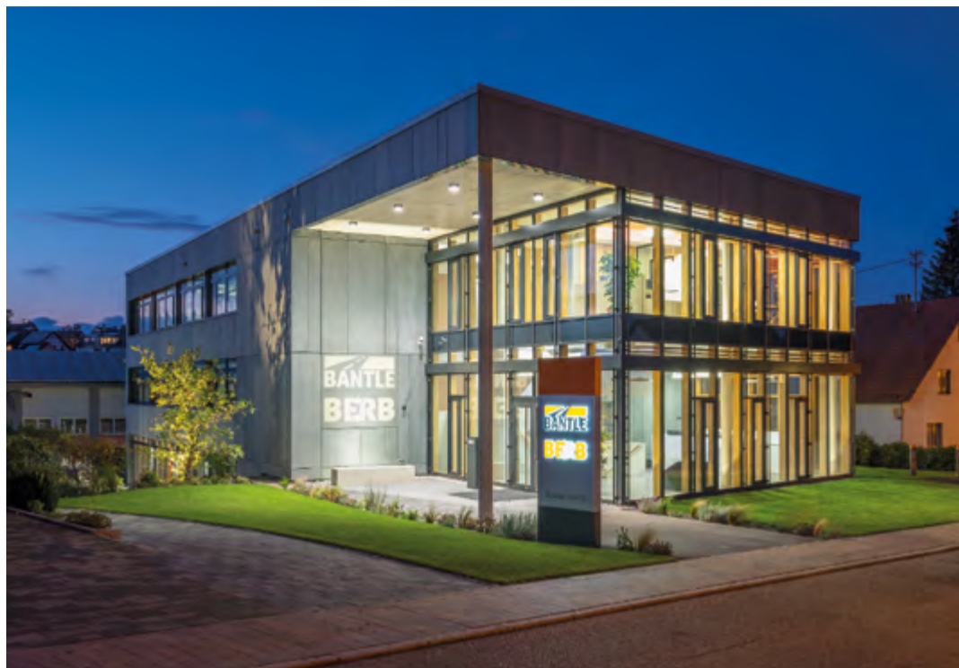
Im neuen Bürogebäude wurde als Basis für die Wärmeerzeugung ein Hybridsystem mit Wärmepumpe installiert.
